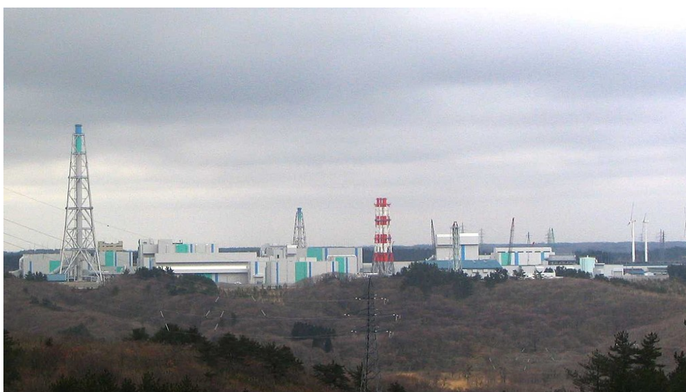
Rokkasho Reprocessing Plant (Source: Wikimedia Commons )
